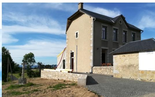
Chantier de Saint Marc : Rampe d'accès et mur de soutien réalisés, pose des menuiseries en cours
