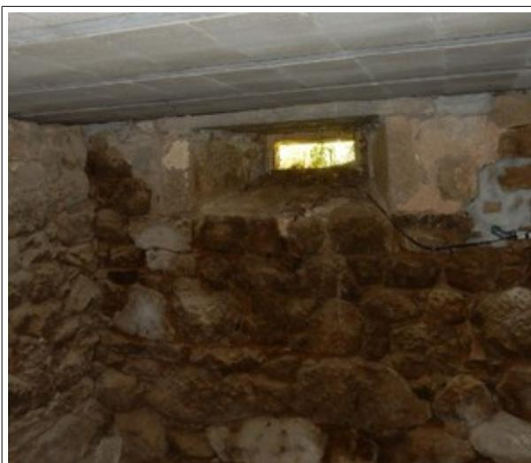
Amenée d'air visible dans un sous-sol
