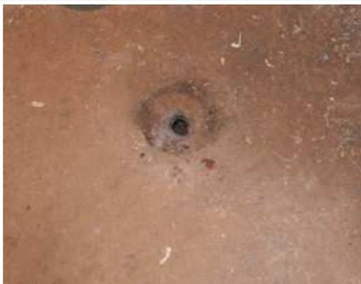
Percement au niveau du plancher bas de la dalle du sous-sol
