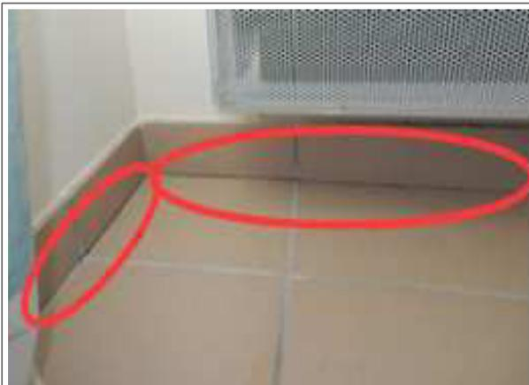
Les fissures périphériques de retrait des dalles bétons constituant le plancher bas des sous-sols et du rez-de-chaussée ou des maisons sur terre-plein
