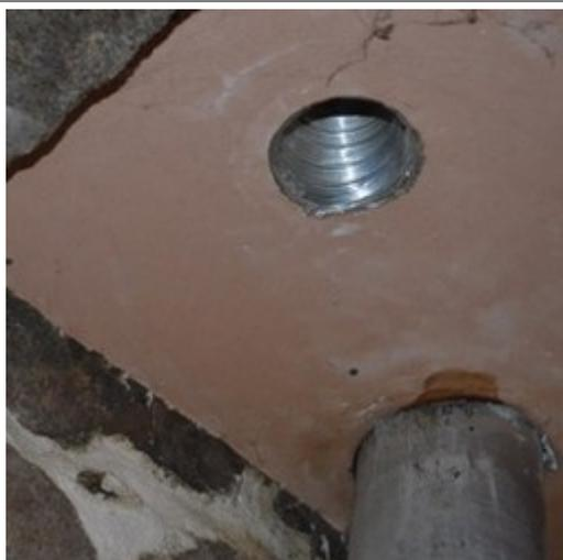
Prise d'air pour le poêle dans le sous-sol
