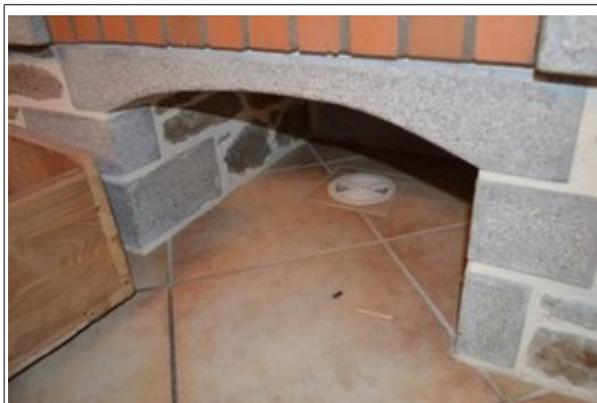
Prise d'air de l'insert sous l'insert prenant son air dans le sous-sol
