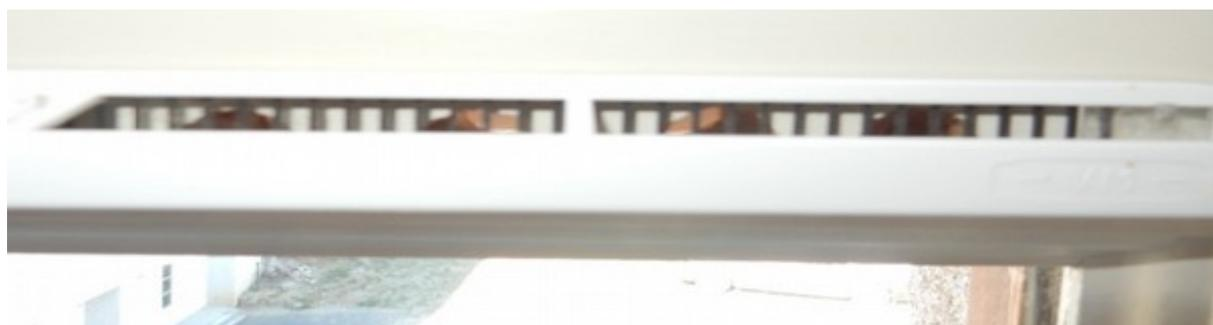
Mortaise de l'entrée d'air non conforme : réalisée à la perceuse
