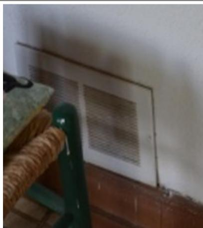
Système de diffuseur d'air inopérant qui permet à l'air contaminé en radon du sous-sol de diffuser aux étages supérieurs
